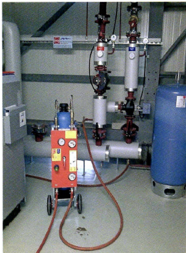
Die Befüllung mit demineralisiertem Heizungswasser ist eine Möglichkeit, die Anforderungen von Kalk- und Korrosionsschutz nach VDI 2035 zu erfüllen
