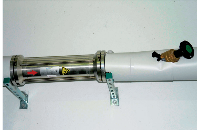
Pro Druckzone besteht das Korrosionsschutzpaket permasolvent aktiv aus jeweils einem Gerät des Typs PT-S 50 EF im Kaltwasserzulauf sowie einem PT-S 40 EFW in der Warmwasserleitung.
