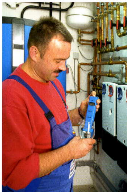
■ Vor der Befüllung der Heizungsanlage sollte die Wasserhärte des örtlichen Trinkwassers mittels eines Leitfähigkeitsmessgerätes überprüft werden.
