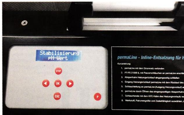
**3** Da es im Heizsystem des Wohnhauses auf Grund eines falschen pH-Werts zu Korrosionsschäden gekommen war, wurde auf diesen besonderes Augenmerk gelegt. Mit einer pH-Wert-Stabilisierungseinheit konnte er passend eingestellt werden.
