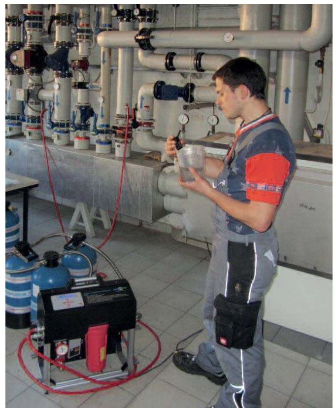
Bild 8 • Andreas Arvay von der Firma Schlittenhardt überprüft den pH-Wert und die Leitfähigkeit des Systemwassers.
