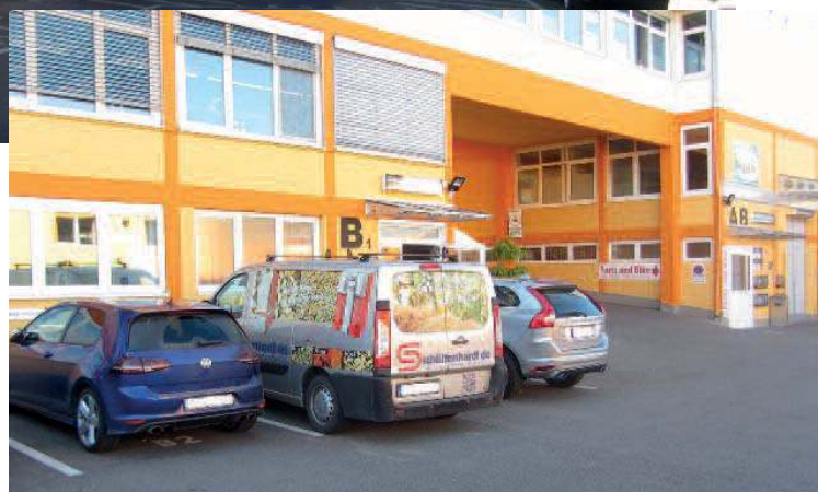
Bild 2 • Die Rudi Schlittenhardt GmbH wurde mit der Aufbereitung des Heizungsfüllwassers beauftragt.
