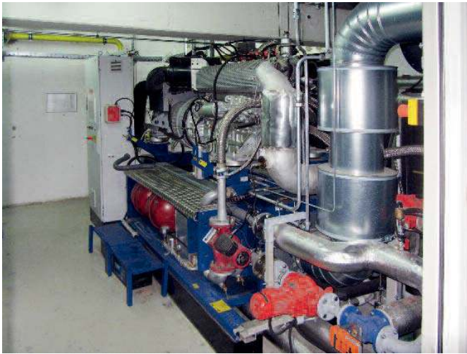
Bild 3 • Die verschiedenen Gebäudekomplexe des Gewerbeparks werden alle von einer Heizungszentrale aus versorgt. Mit einer thermischen Leistung von 275 KW und einer elektrischen Leistung von 201 KW übernimmt ein Blockheizkraftwerk dabei den Löwenanteil der Gesamtleistung. Es wird über einen Gasmotor mit Erdgas betrieben.
