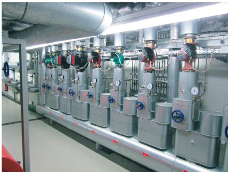
**Bild 3 • Ein Blick in den Heizraum mit dem Heizungsverteiler: Dank der Inline-Entsalzungsmethode permaLine PT-IL 20 lassen sich selbst weit verzweigte und komplexe Füllwasseraufbereitungen einfach umsetzen.**
