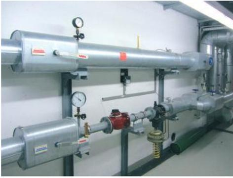
**Bild 2 • Das Bundesverfassungsgericht besteht aus mehreren Gebäudekomplexen, die via Fernheizung über zwei Wärmetauscher mit 400 kW und 800 kW Leistung beheizt werden.**
