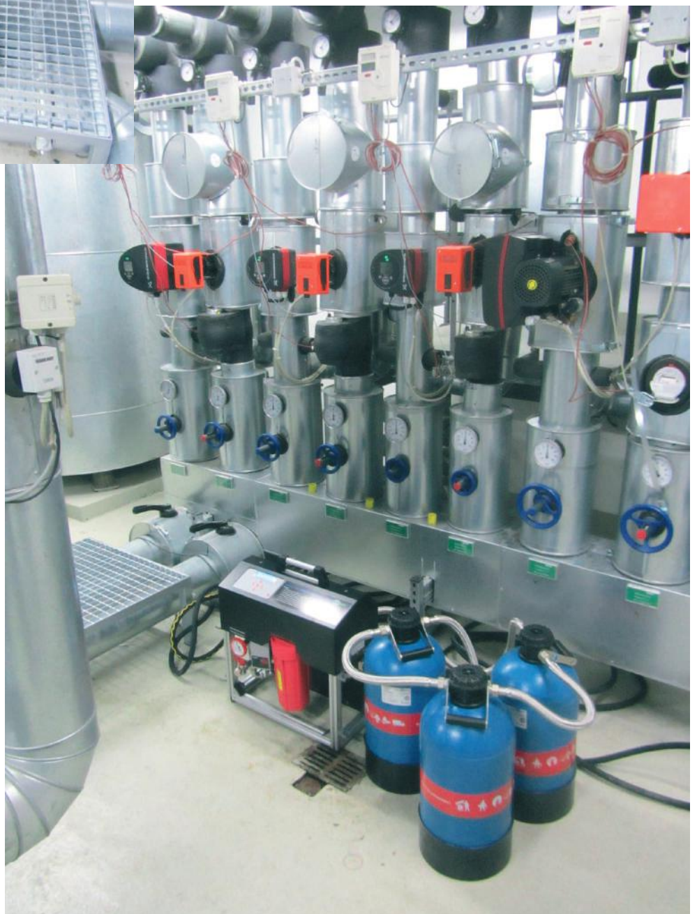
Bild 7 • So ist es denkbar einfach, einen kühlen Kopf zu bewahren: Auch die Kühlkreisläufe lassen sich mit permaLine einfach und sicher aufbereiten.
