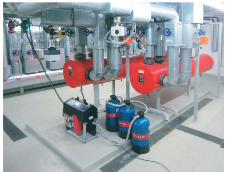
Bild 4 • permaLine lässt sich einfach in den Heizkreislauf einbinden und arbeitet anschließend bei laufendem Betrieb weitgehend selbstständig weiter.
