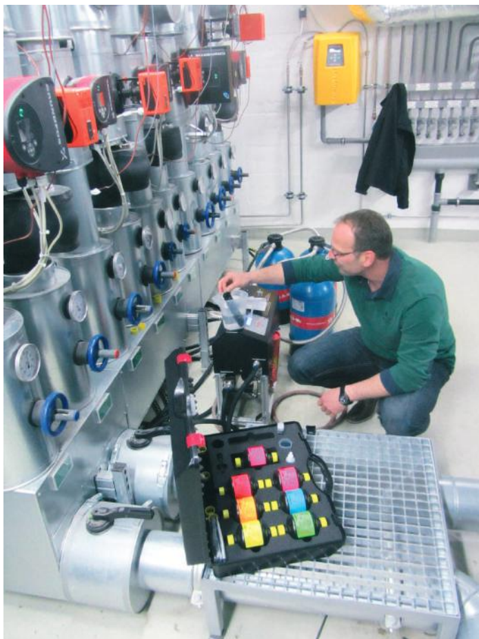
Bild 5 • Alles richtlinienkonform? Wasserexperte Holger Kraus von perma-trade Wassertechnik führt die Messungen von Leitwert und pH-Wert durch.
