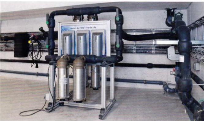
permasolvent-primus ist DVGW-zertifiziert und benötigt keinen Abwasseranschluss. Es muss lediglich an die Trinkwasserinstallation und den Stromkreis angeschlossen werden.
