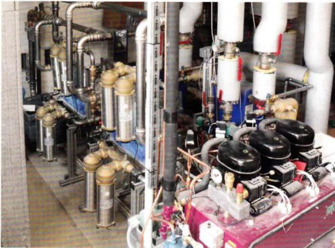
Bei dem Verfahren der Impfkristallbildung werden Mikroelektroden mit Hilfe von Spannungsimpulsen polarisiert. Der Kalk wird von den negativ geladenen Teilchen angezogen und durch periodische Umpolung wieder abgelöst. Die dadurch entstehenden Kristalle können sich nicht mehr im Trinkwassersystem ablagern, sondern werden mit dem Wasserfluss ausgespült.
