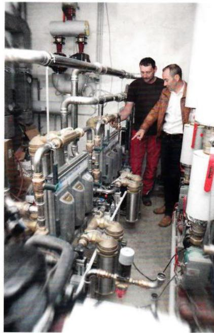
Der größte Wasserdurchfluss des Hotels findet im großen Neubau statt, weshalb dort zwei Systeme des Typs permasolvent-primus PT-P 40/3 installiert wurden. perma-trade Regionalleiter Josef Althammer und Haustechniker Wolfgang Brezner bei der Inbetriebnahme der beiden Kalkschutzsysteme.
